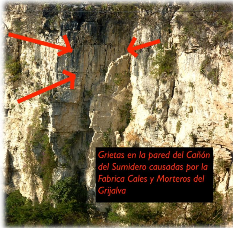
13) Grietas en la pared del Cañón del Sumidero. Tomada del sitio https://sites.google.com/site/denunciacalera/ el 11 de diciembre de 2011
