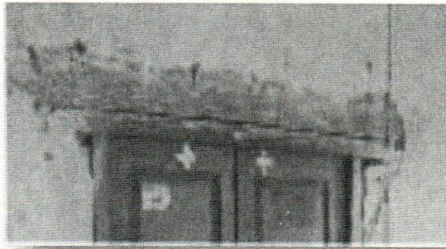
Dinteles de madera en la casa del caporal hacienda Llano Grande.
