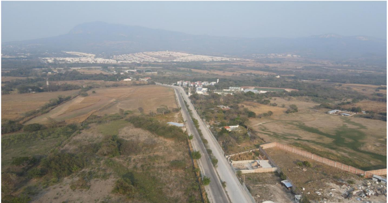
Foto 1.3.- Equipamiento y servicios sobre una arteria secundaria.
